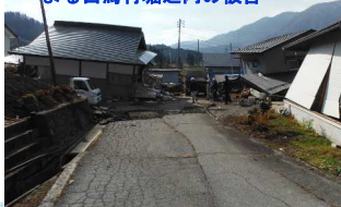
2014年長野県神城断層地震による白馬村堀之内の被害
