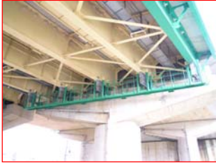
検査路を遮断する落橋防止構造
