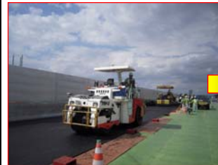
フィニッシャー1台での分割施工
