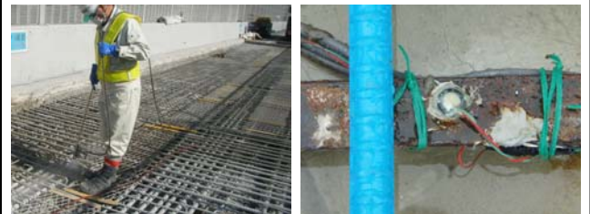
シラン系含浸材による絶縁層の形成
