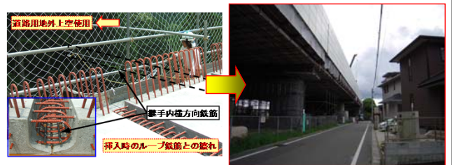
ループ継手内への横方向鉄筋の挿入
