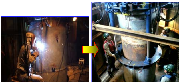
補強鋼板溶接組立
