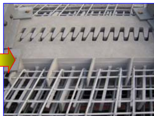
伸縮装置へのAl-Mg合金溶射
