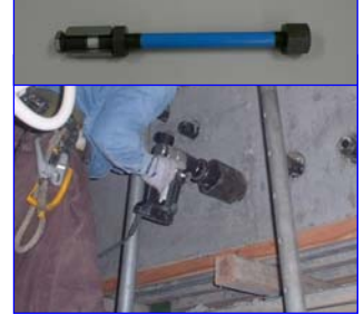
中空PC鋼棒とトルクレンチによる緊張
