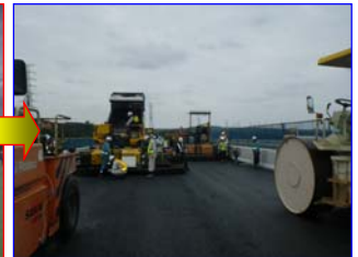
フィニッシャー2台を使用した施工
