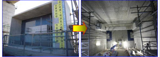
外ケーブル定着部性能確認実験
