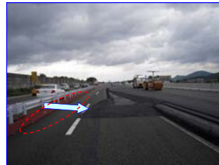
仮設防護柵による路面排水の遮断
