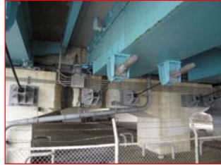
支点部の多くの落橋防止システム
