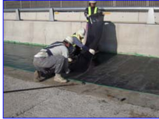
床版上面の炭素繊維補強
