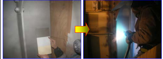
除錆度Sa3.0の素地調整
