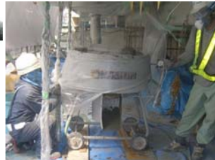
ポリマーセメントモルタルの練混ぜ
