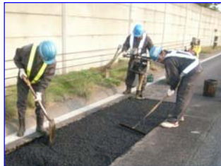
路面の緊急補修
