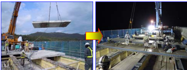
既設床版撤去
