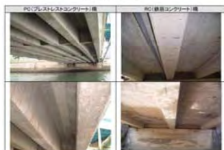
図 3-9 T形橋 上部工写真
