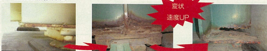
グレードⅡ～Ⅲ (塗替塗装) グレードⅢ～Ⅳ (当て板補修+塗替塗装) グレードⅣ～Ⅴ (部材取替+塗替塗装)
