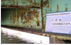
下部工の損傷事例（アル骨）
