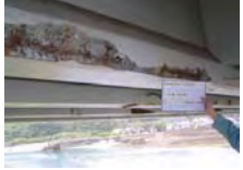
PC桁の損傷事例（塩害）
