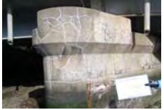
下部工の損傷事例（アル骨）
