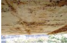
PC桁の損傷事例（塩害）
