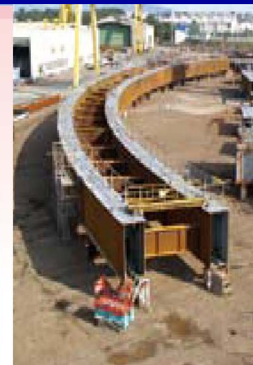
仮組立中の曲線桁
