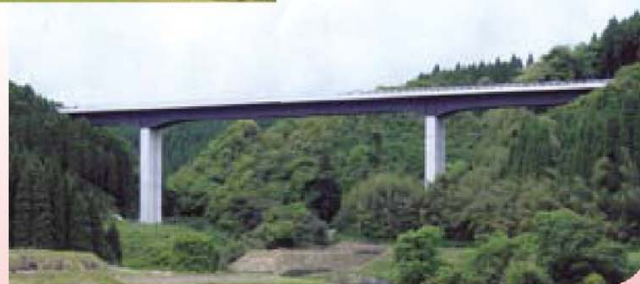
今別府川橋／3径間連続複合ラーメン橋 ▲▶
