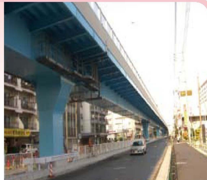
▼新小岩陸橋／4径間連続鋼床版箱桁ラーメン橋2連▲
