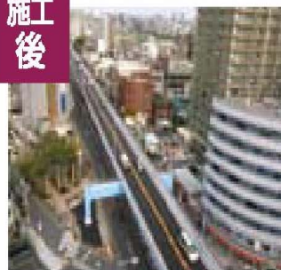
▼新小岩陸橋／4径間連続鋼床版箱桁ラーメン橋2連▲
