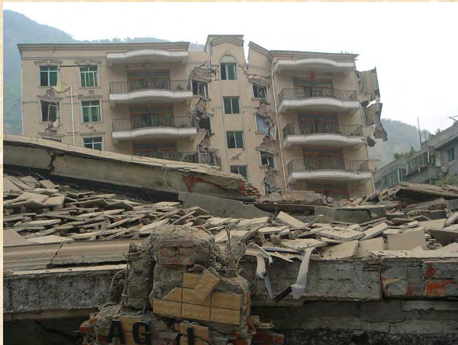
四川大地震での建築物の倒壊
