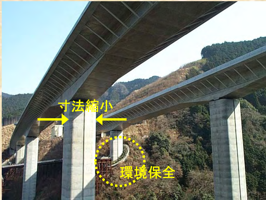
芝川高架橋(第二東名高速道)
