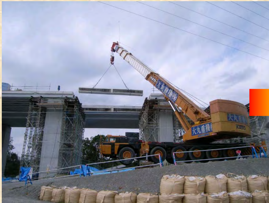
億首川橋(沖縄自動車道)でのRC中空床版橋の架替え
