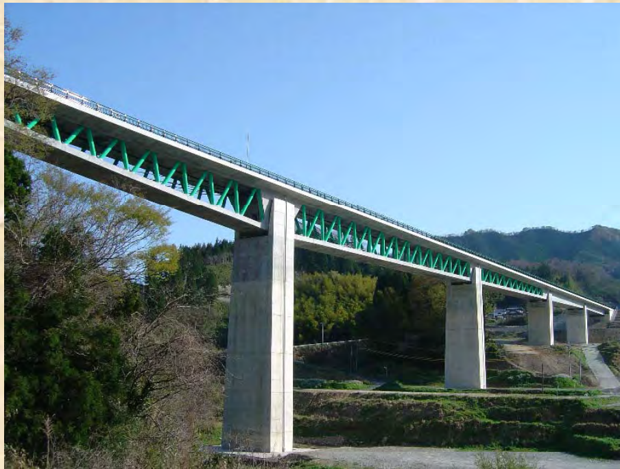
鋼トラスウェブ橋
