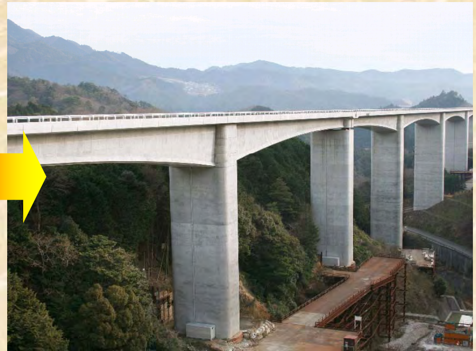
錐ヶ瀧橋(新名神高速道)でのプレテンウェブの適用(張出し施工)
