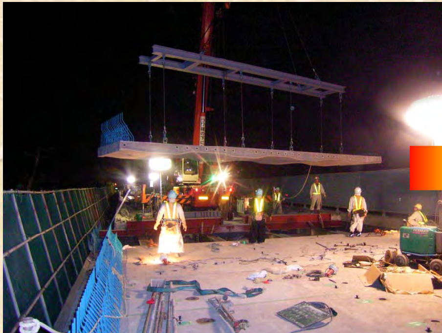
伊芸橋(沖縄自動車道)での床版取替え
