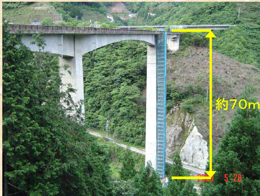
高橋脚橋梁を利用した圧送試験
