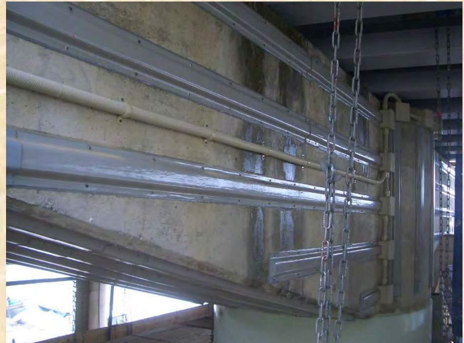
RC橋脚の梁部への電気防食
