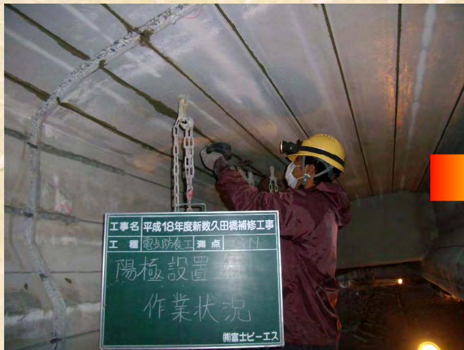
新数久田橋(沖縄総合事務局)でのチタン陽極を用いた電気防食
