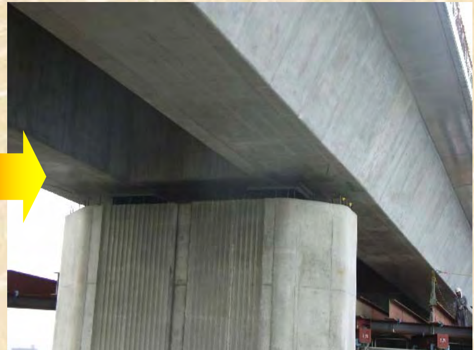
中新田高架橋(さがみ縦貫道)でのプレテンウェブの適用(固定支保工施工)
