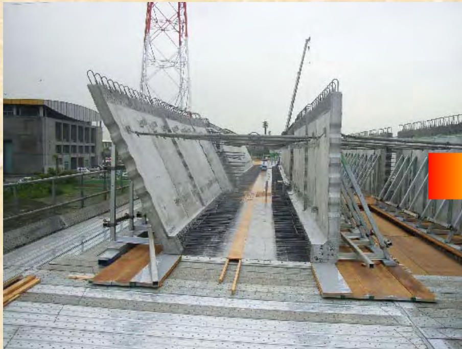
中新田高架橋(さがみ縦貫道)でのプレテンウェブの適用(固定支保工施工)
