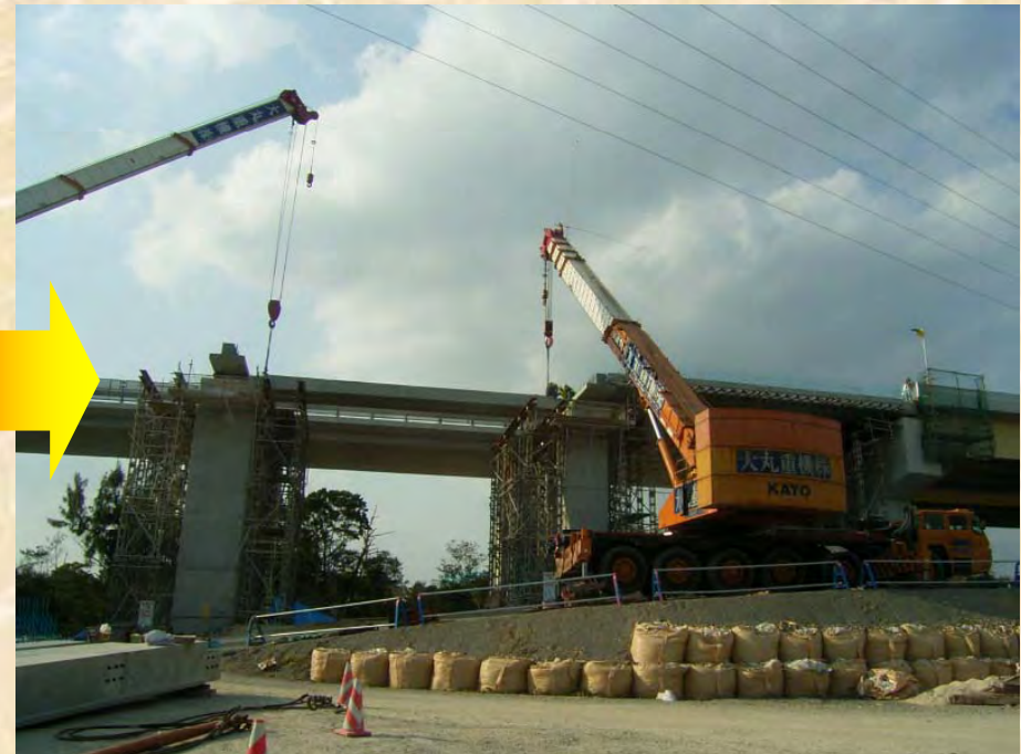
億首川橋(沖縄自動車道)でのRC中空床版橋の架替え
