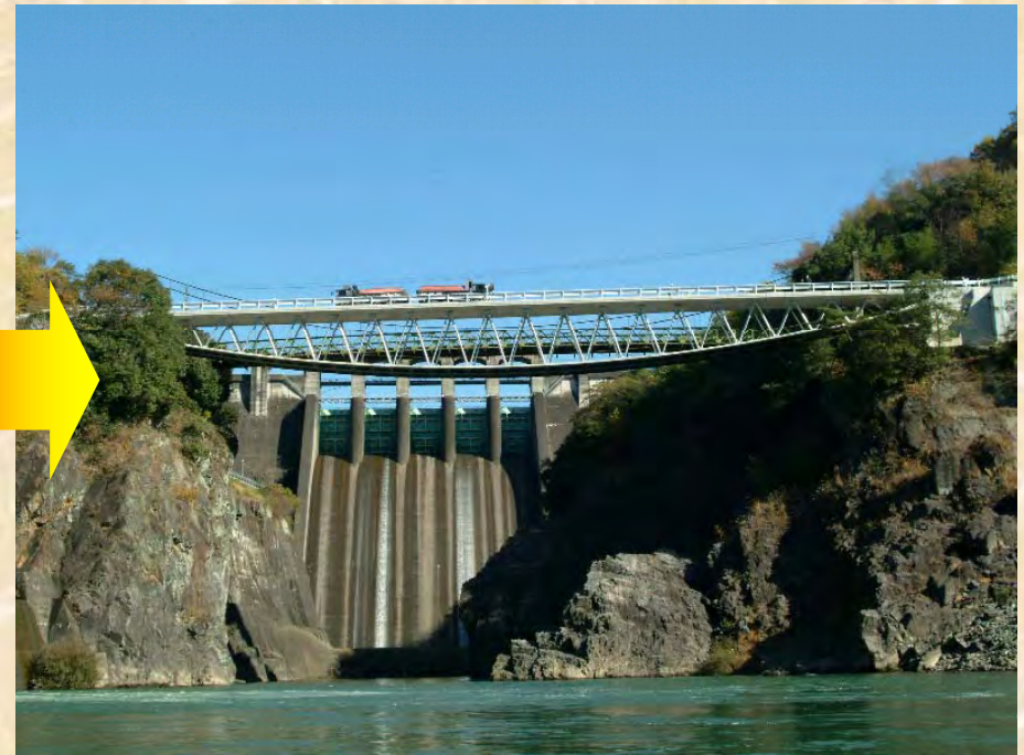
ダム建設用の仮橋での懸垂架設の適用
