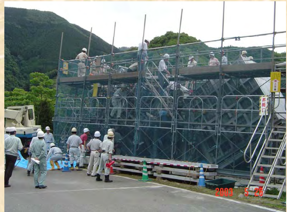
アーチリングを想定した充填性確認試験
