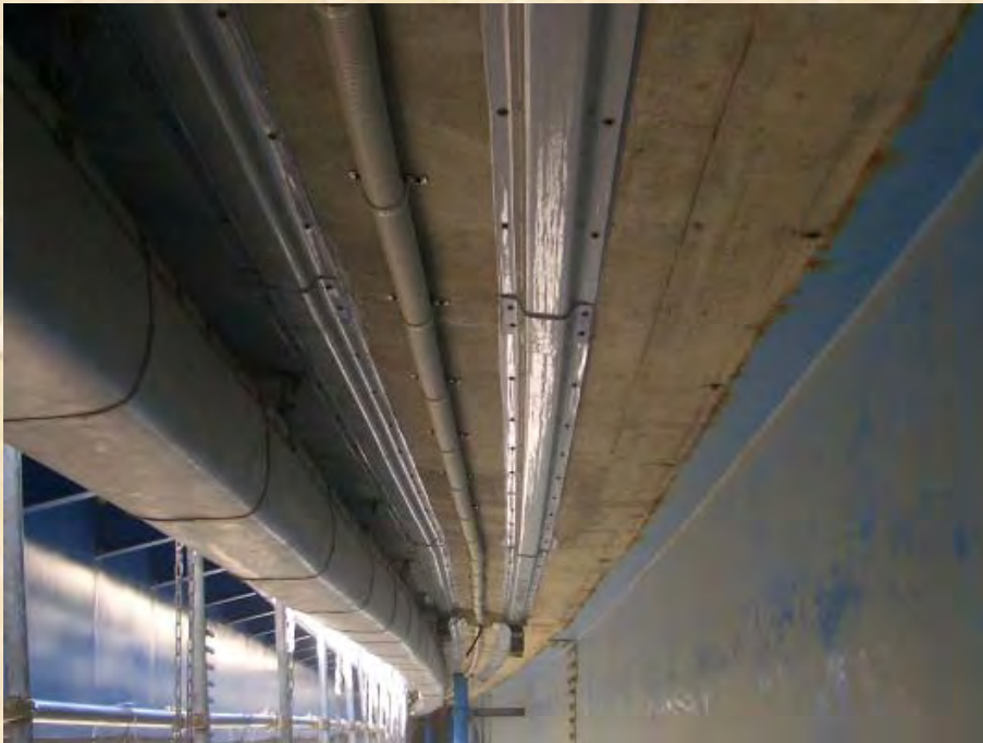
鋼橋のRC床版への電気防食
