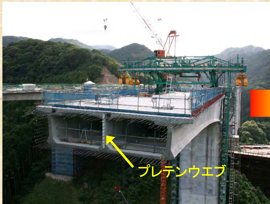
錐ヶ瀧橋(新名神高速道)でのプレテンウェブの適用(張出し施工)
