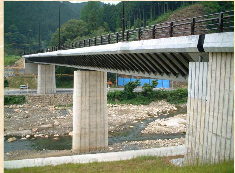
苫田ダム県道橋(中国地方整備局)
