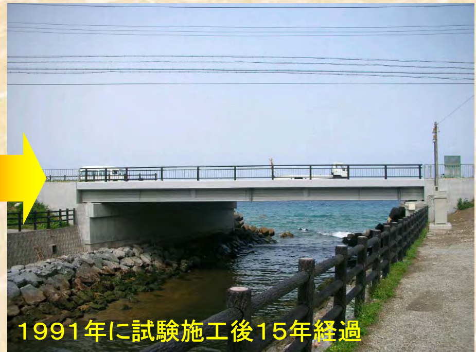
新数久田橋(沖縄総合事務局)でのチタン陽極を用いた電気防食
